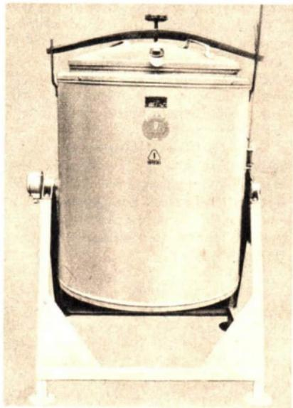
Abb. 98/3. Elektrischer Futterdämpfer
