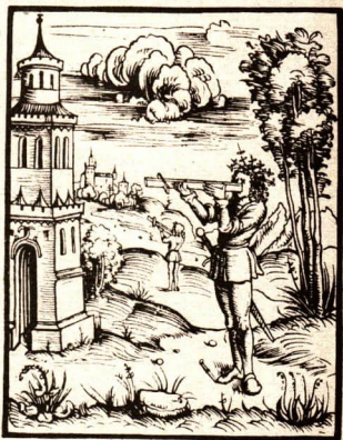
B 75: Der Jakobsstab im Gebrauch. Darstellung aus dem Jahre 1531
