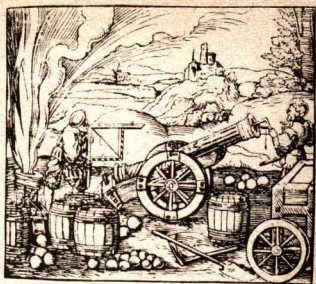
B 74: Richten von Geschützen mit Hilfe geometrischer Instrumente, Europa, Mitte des 16. Jahrhunderts
