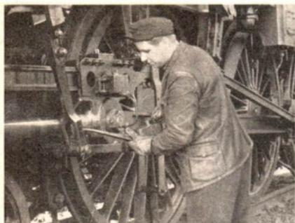
17/1 Alle beweglichen Teile an Maschinen müssen abgeschmiert werden, um Reibungskräfte und Verschleiß zu verringern.
