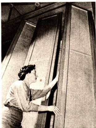
Abb. 147/1. Durch schwenkbare Holztafeln kann die Nachhallzeit des Raumes verändert werden
