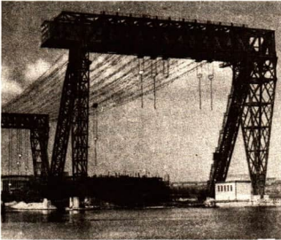
Bild 126/1 Kabelkrananlage der Warnowwerft
