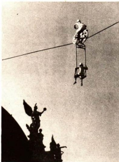
**Labiles Gleichgewicht.** Befindet sich der Schwerpunkt gegenüber dem Unterstützungspunkt in der höchstmöglichen Lage, so bezeichnet man diese Gleichgewichtsart als das **labile Gleichgewicht** (Bild 133/3). Der Schwerpunkt wird bei einer kleinen Lageänderung stets gesenkt.
