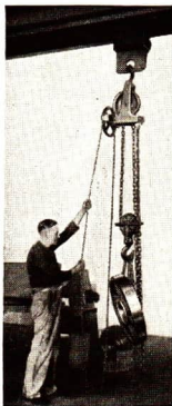
Abb. 92. Schraubenflaschenzug für Handbetätigung
