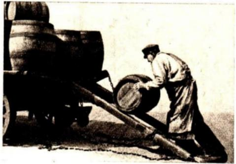
Abb. 125 Die schiefe Ebene (Schrotleiter) hilft die Last heben.
