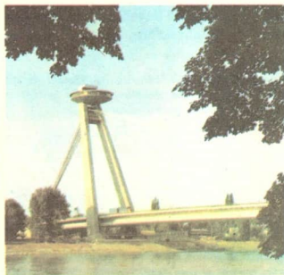
Bild 59/1 Hängebrücke in Bratislava. Die Fahrbahn hängt an Stahlseilen.
