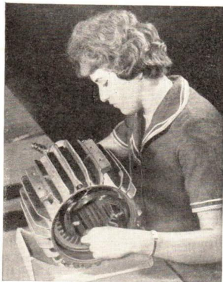
87/2 Die Spulen der Ständerwicklung eines Drehstrommotors werden von der Wicklerin in die Nuten des Blechpakets eingelegt
