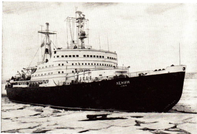
182/1 Der Eisbrecher „Lenin“ ist mit drei Druckwasserreaktoren ausgestattet und arbeitet mit angereichertem Uran. Der Eisbrecher kann ohne Brennstoffaufnahme über 1 Jahr laufen und verbraucht dabei etwa 80 kg Uran
