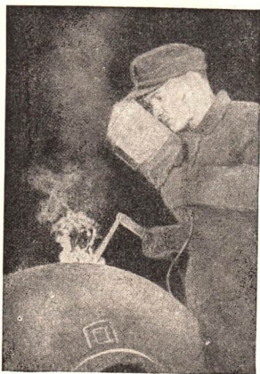
Abb. 182/2. Elektrisches Lichtbogenschweißen
