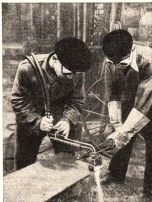
Abb. 29/1. Autogenes Schneiden von Kesselblechen
