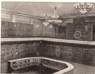
Abb. 234/2. Zentrale Steuerungsanlage des Synchrophasotrons in Dubna. Die Steuerung ist in einem besonderen Gebäude untergebracht.
