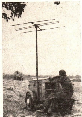
Abb. 139/2. UKW-Sprechfunkanlage einer Maschinen-Traktoren-Station
