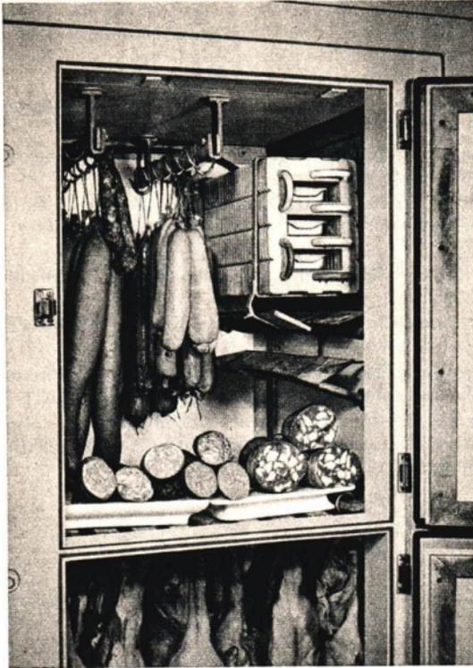
Abb. 104. Teilansicht eines Kühltanks in einer Konsum-Verkaufsstelle. Im Kühlraum sind oben rechts die Kühlrippen der Kühlschlangen sichtbar. Diese werden von Dämpfen sehr tiefer Temperatur durchströmt.
