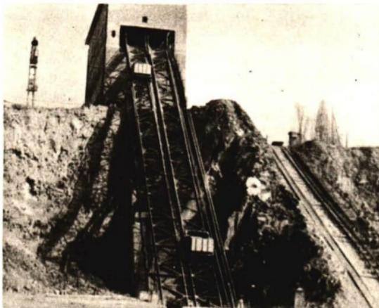
ebenfalls Schrägaufzüge, durch die das Erz und der Koks auf die Gichtbühne transportiert werden. *Bergbahnen* mit großen Steigungen sind die Zahnradbahnen und die Seilbahnen (Abb. 47/1).
