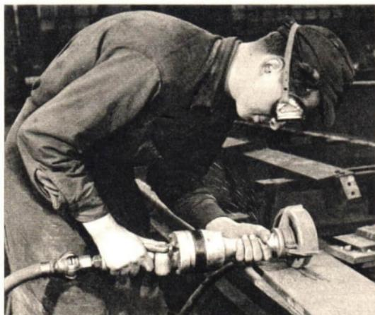
Abb. 129/1. Mit Preßluft angetriebene Schleifmaschine
