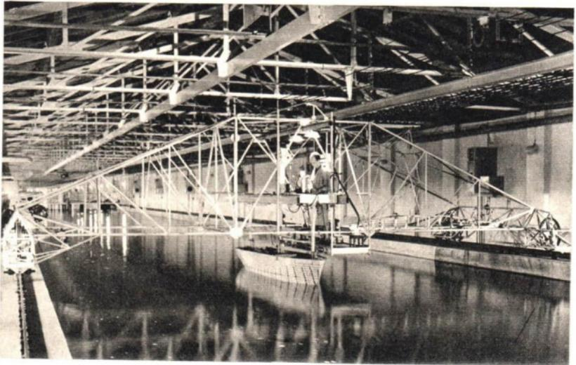
Abb. 136/2. Schleppkanal der Schiffbauversuchsanstalt Berlin-Potsdam
