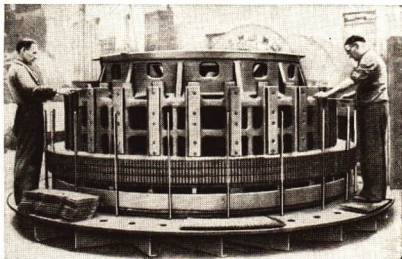
Abb. 49/1. Montage eines großen Trommelankers
