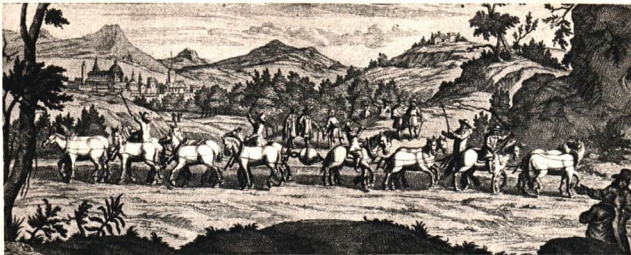
Abb. 118. Otto von Guericke's berühmter Versuch (nach einem alten Kupferstich). Durchmesser der Kugeln 42 cm. Erst durch Vorspannen von acht Pferden auf jeder Seite konnten die Kugeln auseinandergerissen werden.
