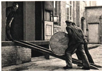
Abb. 165. Die Schrotleiter als Beispiel einer schiefen Ebene
