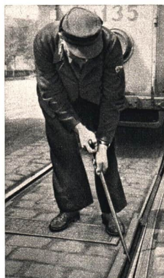
Abb. 131. Weichenstellhebel der Straßenbahn
