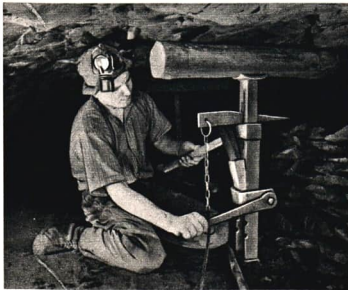
Abb. 170. Bergmann beim Festklemmen einer Deckenstütze in einer Kupferschiefergrube des volkseigenen Mansfelder Bergbaues
