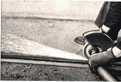
Abb. 180. Funkensprühen am Schleifstein beim Glattschleifen einer Straßenbahnschiene. Die Funken fliegen tangential davon.
