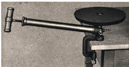
Abb. 116 Luftpumpe mit Teller zur Aufnahme eines Rezipienten
