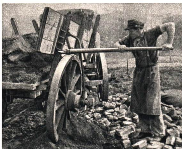
Abb. 130. Hebebaum beim Hochheben der Seitenwand eines Wagens
