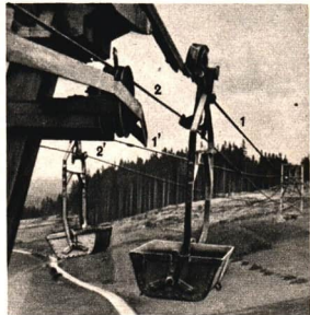
Abb. 147. Seilhängebahn der Sosatalsperre Die Bahn diente während des Baus der Talsperre zum Antransport der Baustoffe.
