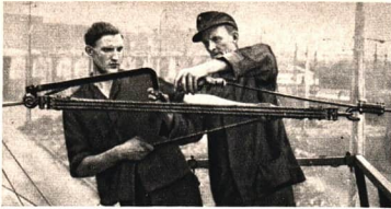
Abb. 156. Spannen des Fahrdrabtes einer elektrischen Straßenbahn beim Ausführen einer Reparatur. Die beiden Arbeiter stehen auf der Plattform eines Turmwagens. Sie haben an die beiden Enden des Drahtes zwei flache, mit Haken versehene Haltevorrichtungen geklemmt. Mit Hilfe eines dazwischen befestigten Flaschenzuges werden die Drahtenden gespannt. Von den sechs Verbindungsseilen werden drei durch die davorliegenden verdeckt.
