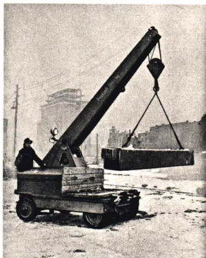
Abb. 102. Elektrokran, hergestellt von der Transportanlagenfabrik Bleichert der AG Transmasch, Leipzig, bei der Arbeitsverwendung auf dem Baugelände der Stalinallee in Berlin. Sowohl der Antriebsmotor des Fahrzeuges wie der Motor des Kranes entnehmen ihren Strom aus einer Batterie.
