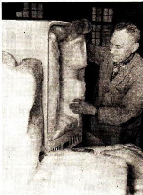
Abb. 101 Auskleiden eines Kühlschranks mit Glaswolle
