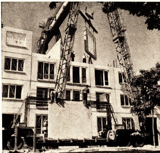
Abb. 40 Großplattenbaustelle in Hoyerswerda
