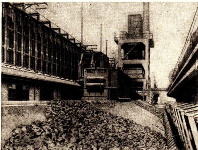
Abb. 57 Kammeröfen, Löschwagen und Löschtturm im VEB Gasversorgung Berlin, Werk Lichtenberg
