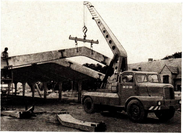
Abb. 41 Montage eines Stallgebäudes aus Stahlbetonteilen in der LPG Brüsewitz (Landkreis Schwerin)
