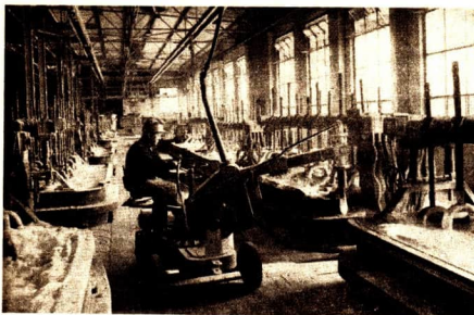
Abb. 57 Elektrolysezellen zur Herstellung von Aluminium im VEB Chemiekombinat Bitterfeld
