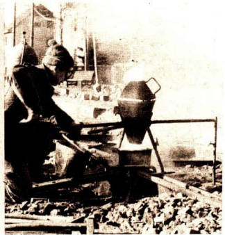
Abb. 55 Schematische Darstellung des Tiegels, in dem in der Technik die Redoxreaktion zwischen Eisen(II)-oxid und Aluminium durchgeführt wird
