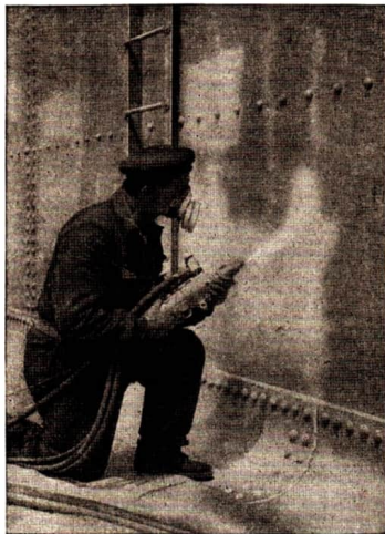
Abb. 35 Spritzverzinken eines Troges vom Schiffshebewerk Rothensee
