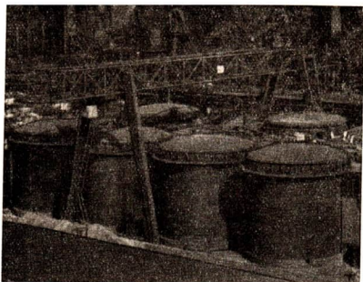
Abb. 37 Die Umsetzung des Synthesegases erfolgt in der Kontaktofenbatterie (VEB Synthesewerk Schwarzheide)
