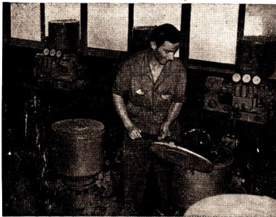
Abb. 56 Bedienungsraum der Hochdruckschmieranlage eines Eimerkettenbaggers
