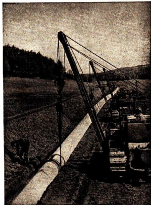
Abb. 23 Bau einer Erdölleitung in der Sowjetunion
