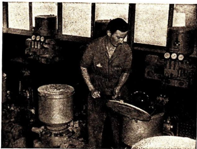
Abb. 20 Bedienungsraum der Hochdruckschmieranlage eines Eimerkettenbaggers
