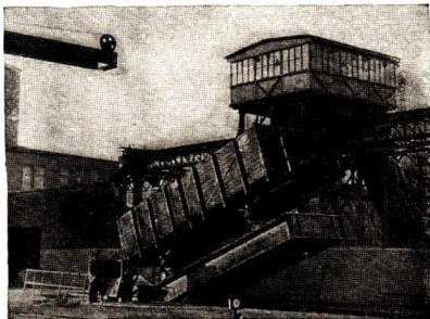
Abb. 77 Entladevorrichtung für Waggons im VEB Zuckerfabrik Delitzsch
