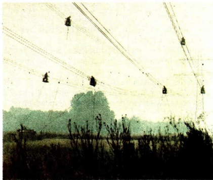
Abb. 35 Montage von Kupferleitungen
