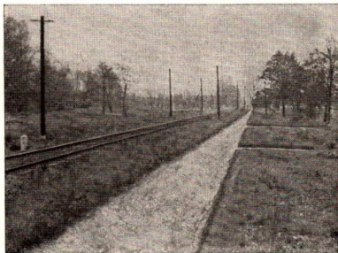
Abb. 5 Feuerschutzgraben an einer Eisenbahnstrecke
