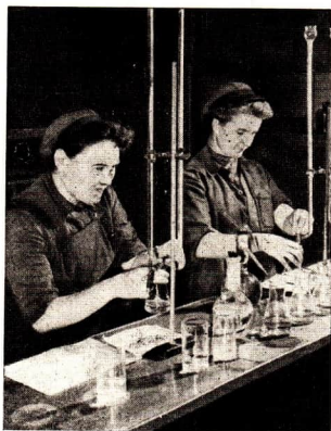
Abb. 97 Chemiefacharbeiterinnen beim Arbeiten mit der Bürette
