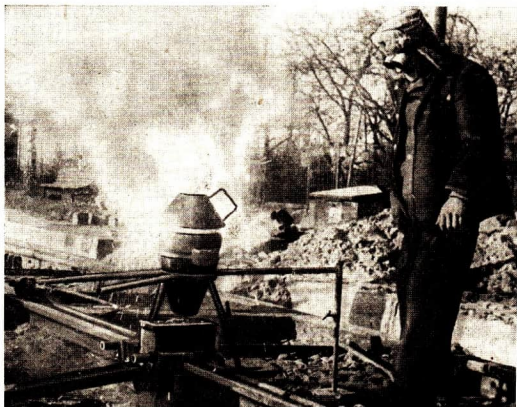
Schweißen von Straßenbahnschienen nach dem aluminothermischen Verfahren
