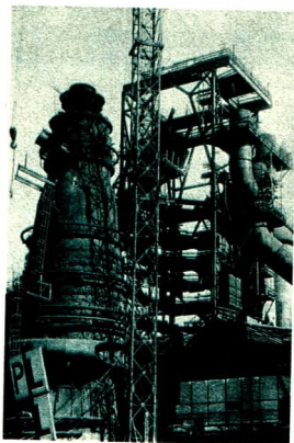
Abb. 61 Im VEB Eisenhüttenkombinat Ost, Eisenhüttenstadt, wird ein neuer Hochofen in das Stahlgerüst eingefahren. Im Hintergrund sind Winderhitzer zu sehen.
