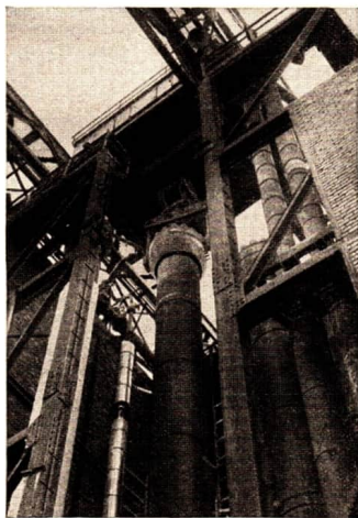
Abb. 36. Teilansicht einer Hydrieranlage.
