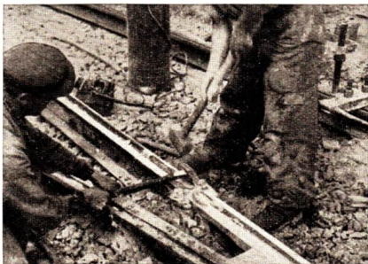
Abb. 42 d) Abschlagen der Gußgrate
