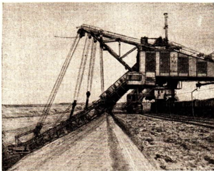
Abb. 18. Eimerkettentiefbagger bei der Abraumförderung.
