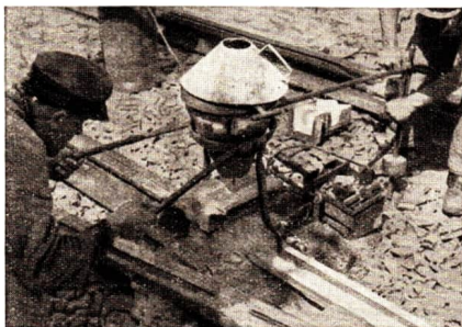
Abb. 42 b) Ansetzen des Tiegels
