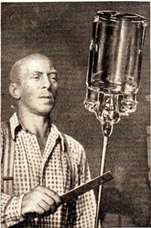
Abb. 39: Herstellen von Glasröhren im Handbetrieb.
