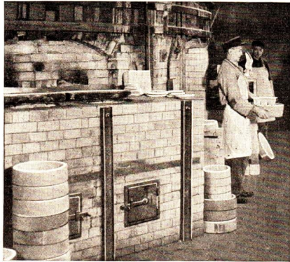
Abb. 47: Porzellanrundofen der Staatlichen Porzellanmanufaktur Meißen. In dem Porzellanrundofen werden die vorgetrockneten Gegenstände gebrannt. Die Abbildung zeigt den unteren Teil des Ofens, in dem der Glatt- oder Garbrand bei einer Temperatur von 1400 bis 1500° C durchgeführt wird. Dabei schmilzt die Glasur, die aus einem staubartigen Gemisch aus Kaolin, Quarz, Feldspat und Marmor hergestellt wird, zu einer glasartigen Masse. Der Scherben sintert zu dem durchscheinenden Porzellan zusammen.
