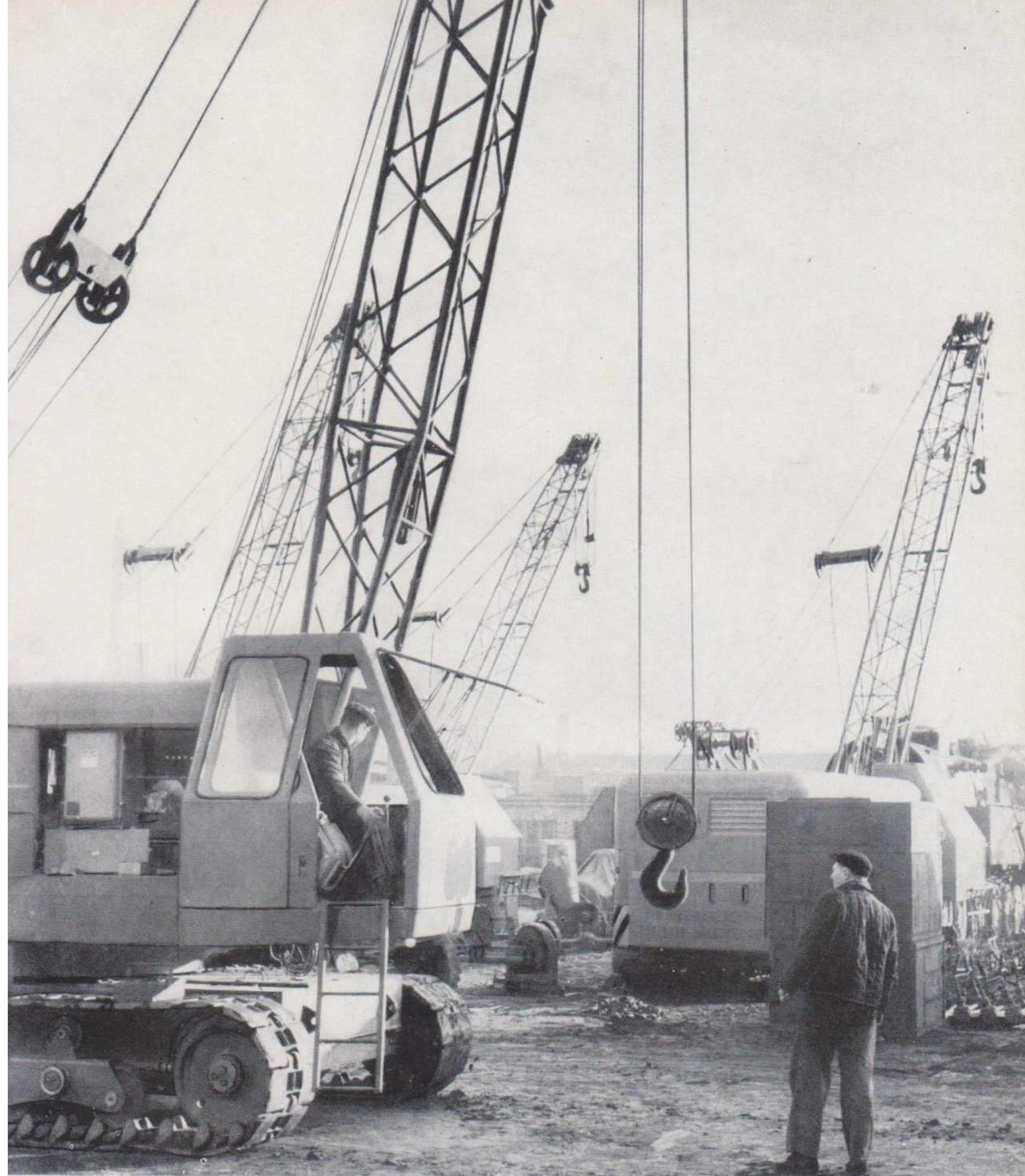
Mobilkrane im Depot. Diese Krane fahren auf Gleisketten und können deshalb in jedem unwegsamen Gelände eingesetzt werden
