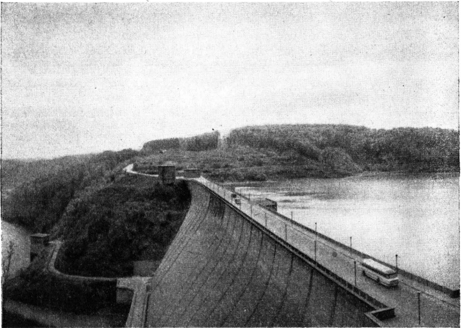
Abb. 3 Staumauer der Rapp-Bode-Talsperre
