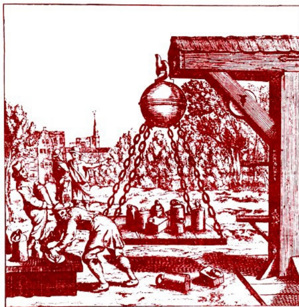
Bild 110: Versuch, hängende Magdeburger Halbkugeln mit einer Ladung zu trennen. Nach "Experimenta nova Magdeburgica de vacuo spatio", Otto von Guericke, Amsterdam 1672
