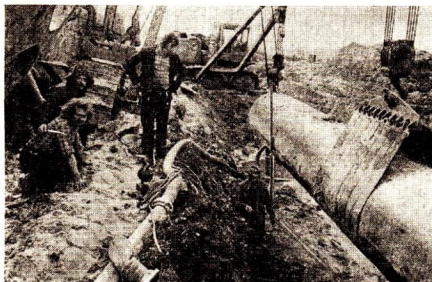
Abb. 8 Verlegen der Erdgasleitung von Orenburg zur Westgrenze der UdSSR
