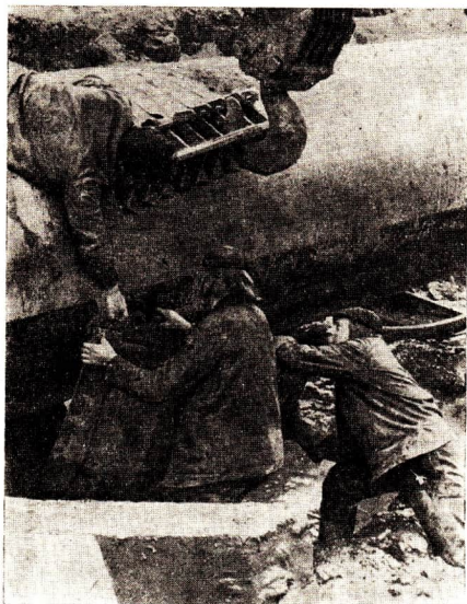
Abb. 9 FDJ im Einsatz an der „Drushba-Trasse“
