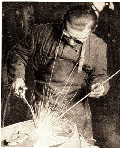
Abb. 29: Autogenes Schweißen eines Rades. Aufgenommen in einer MAS Großreparaturwerkstatt.
