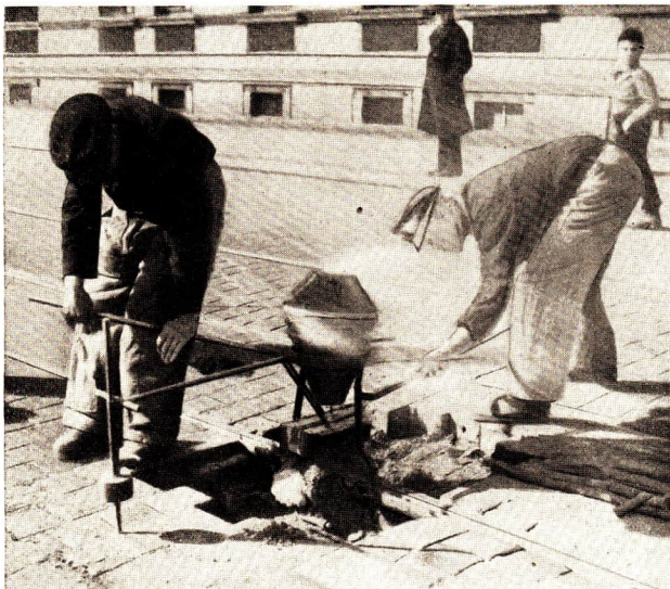
Abb. 33: Thermitschweißen.
