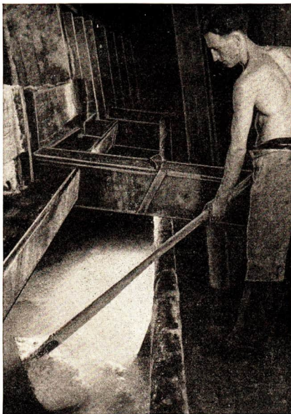
Abb. 57: Eindampfen der Sole: Das Salz wird „gekrückt“.
