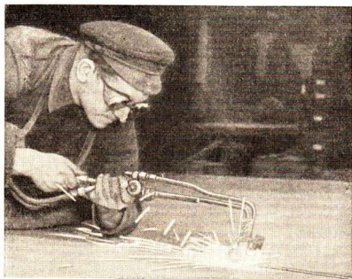
Abb. 30: Autogenes Schneiden einer Stahlplatte. Aufnahme aus der Volkswerft Stralsund.
