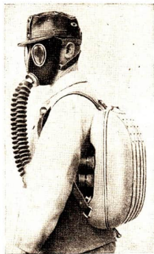
Abb. 18: Bergmann mit Sauerstoffgerät .
