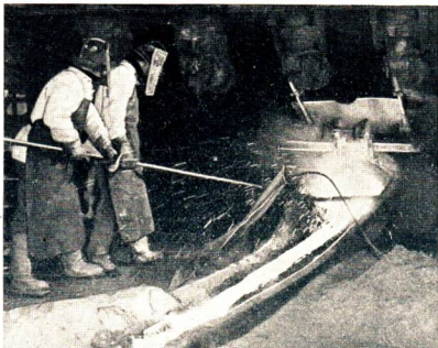
Abb. 117 Roheisenabstich an einem Niederschachtofen im VEB Eisenwerke West, Calbe/Saale
