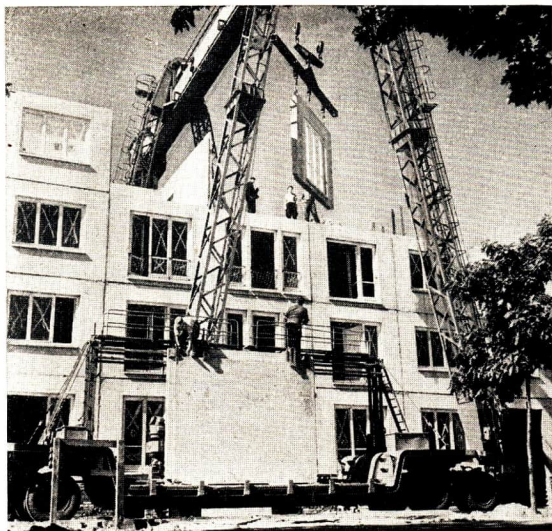
Abb. 43 Eine Großplattenbaustelle in Hoyerswerda
