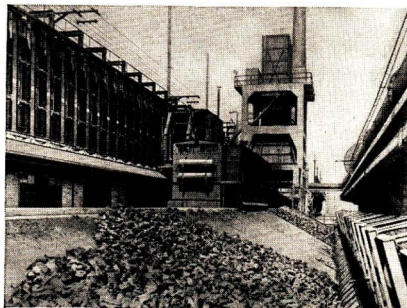
Abb. 62 Kammeröfen, Löschwagen und Löschturm im VEB Gasversorgung Berlin, Werk Lichtenberg
