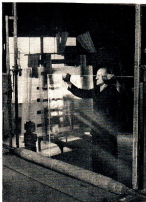
Abb. 94 Abnehmen der Glasscheiben an der Tafelglasziehmaschine in einer Torgauer Glashütte
