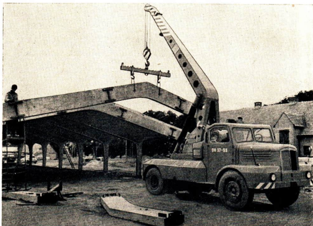
Abb. 44 Montage eines Stallgebäudes aus Betonfertigbauteilen mit Hilfe des modernen Auto-drehkranes vom Typ „Panther“ in einer landwirtschaftlichen Produktionsgenossenschaft
