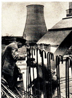
Abb. 36 Herstellen von Stahlbeton beim Aufbau im Kombinat „Schwarze Pumpe“
