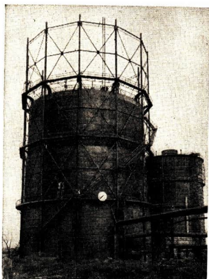
Abb. 64 Glockengasbehälter im VEB Mineralölwerk Lützkendorf
