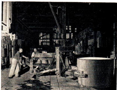
Abb. 86 Transport eines Glashafeners mit flüssigem optischen Glas
