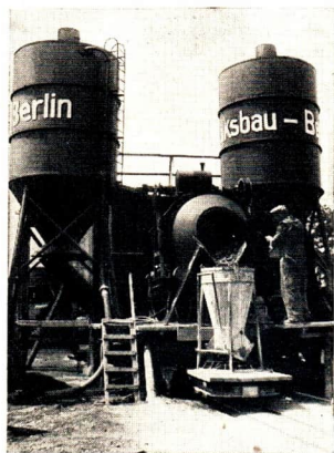
Abb. 35 Betonmischanlage auf einer Baustelle in unserer Republik
