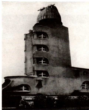
Sonnenobservatorium Potsdam. Die Sonne steht ständig unter Kontrolle. Ihrer Beobachtung in der DDR dient vor allem der Einsteinturm in Potsdam. Sein großes, unbewegliches Fernrohr steht senkrecht zur Erdoberfläche. Mit Spiegeln wird das Sonnenlicht oben in das Rohr hinein- und unten (für die Untersuchungen) wieder herausgelenkt.
