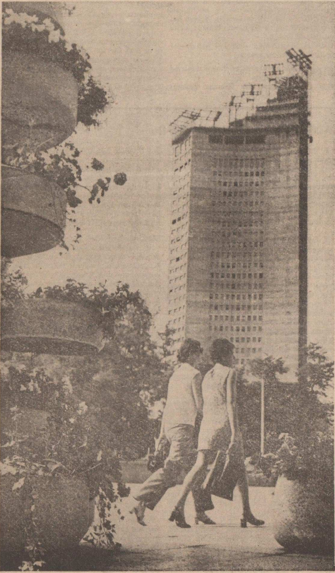
Der LEIPZIGER UNI-RIESE - ein neues Wahrzeichen der Messestadt - im Bau.
