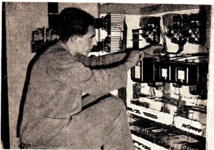
Elektromonteur bei der Montage einer Stromversorgungsanlage. Das Metall Kupfer, mit dem wir uns im 4. Kapitel beschäftigen werden, ist ein wichtiges Gebrauchsmetall. Wegen seiner guten elektrischen Leitfähigkeit wird es sehr vielseitig in der Nachrichtentechnik, der Rundfunktechnik und der Fernsehtechnik verwendet. Außerdem hat es für die chemische Industrie und auch andere Industriezweige große Bedeutung. Die Kupferindustrie ist daher ein wichtiger Zweig unserer Volkswirtschaft.
