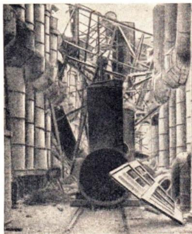
Abb. 49 Die durch Luftangriffe zerstörte Kohlenmonoxyd-Konvertierung der Leuna-Werke
