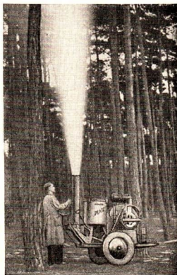
Abb. 281/3. Pulverzerstäuber mit IFA-Zweitaktmotor El 308
