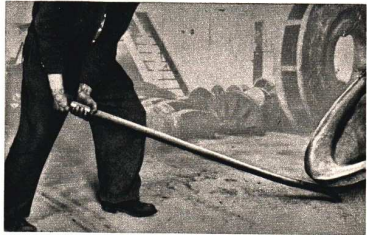
Abb. 133. Verwendung einer Brechstange zum Anheben eines schweren Gegenstandes
