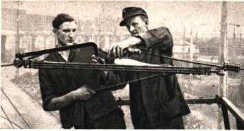
Abb. 156. Spannen des Fahrdrabtes einer elektrischen Straßenbahn beim Ausführen einer Reparatur. Die beiden Arbeiter stehen auf der Plattform eines Turmwagens. Sie haben an die beiden Enden des Drahtes zwei flache, mit Haken versehene Haltevorrichtungen geklemmt. Mit Hilfe eines dazwischen befestigten Flaschenzuges werden die Drahtenden gespannt. Von den sechs Verbindungsseilen werden drei durch die davorliegenden verdeckt.
