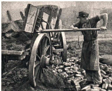
Abb. 130. Hebebaum beim Hochheben der Seitenwand eines Wagens
