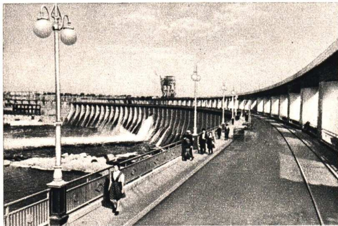
Abb. 101. Staumauer bei Saporoshje im Unterlauf des Dnepr
