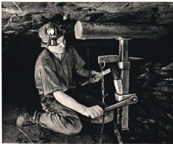
Abb. 170. Bergmann beim Festkeilen einer Deckenstütze in einer Kupferschiefergrube des volkseigenen Mansfelder Bergbaues
