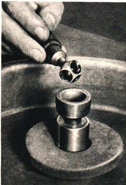
Abb. 32. Polieren von Linsen mit der Hand, aufgenommen auf dem Ausstellungsstand der Rathenower Optischen Werke (ROW) in der Fünfjahrplanausstellung in Berlin. Die Linsen sind auf einen halbkugelförmigen Linsenträger gekittet und werden durch eine rotierende Schale poliert.
