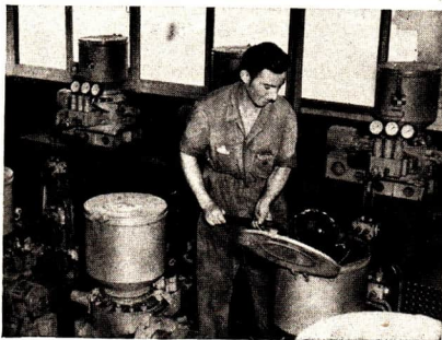
Abb. 38 Bedienungsraum der Hochdruckschmieranlage eines Eimerkettenbaggers
