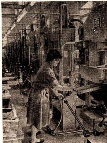
Abb. 115 Preßautomaten für Preßmassen im VEB Plastik-Werk Berlin
