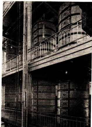
Abb. 50 Destillierkolonnen im VEB Gärungschemie Dessau
