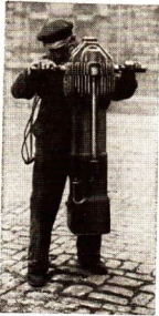
Abb. 263 Handramme mit Motorantrieb
