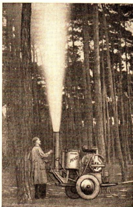
Abb. 297. Pulverzerstäuber mit IFA-Zweitaktmotor EI 308
