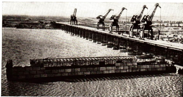
Abb. 144. Teil der Staumauer von Zimljanskaja (UdSSR) Länge der Mauer 500 m, Menge des angestauten Wassers 12,6 Md. m 3
