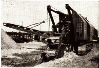
Abb. 80. Grabenbagger des VEB Schwermaschinenbau Karl Liebknecht, Magdeburg, beim Ausheben eines Grabens. Mittels einer Eimerkette wird das Erdreich ausgehoben und einem Förderband zugeführt, das über einen Ausleger läuft. Dieses Förderband schüttert das Erdreich entweder in ein Transportfahrzeug oder auf eine Halde.
