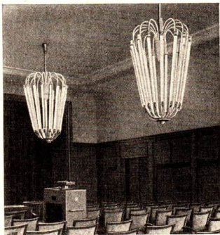
Abb. 125/1. Mit Leuchtstoffröhren bestückte Beleuchtungskörper in einem Vortragssaal
