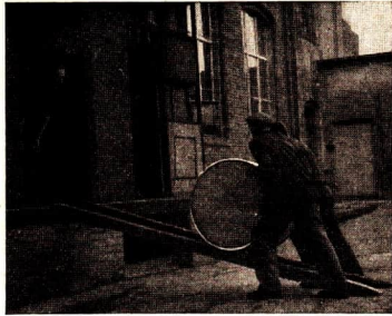
Abb. 79/1. Die Schrotleiter als Beispiel einer schiefen Ebene.
