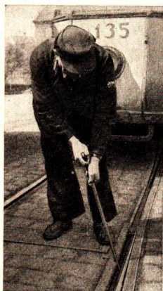
Abb. 63/1. Weichenstellstange bei der Straßenbahn
