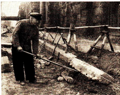
Abb. 59/2. Anheben eines schweren Steines mit Hilfe eines Hebebaumes
