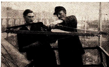
Abb. 72/1. Spannen des Fahrdrabtes einer Straßenbahn beim Ausführen einer Reparatur. Die beiden Arbeiter stehen auf der Plattform eines Turmwagens. Sie haben an die beiden Enden des Drahtes zwei flache, mit Haken versehene Haltevorrichtungen geklemmt. Mit Hilfe eines dazwischen befestigten Flaschenzuges werden die Drahtenden gespannt. Von den sechs Verbindungsseilen werden drei durch die davorliegenden verdeckt.
