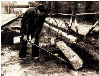
Abb. 59/1. Anheben eines schweren Steines mit Hilfe einer Brechstange
