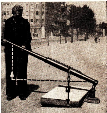
Abb. 106/1. Anheben eines Kanaldeckels
