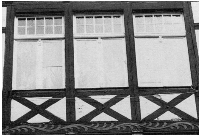
Abb. 49. a) Streifenmuster am mittleren Querbalken (Wohnhaus in Quedlinburg)
