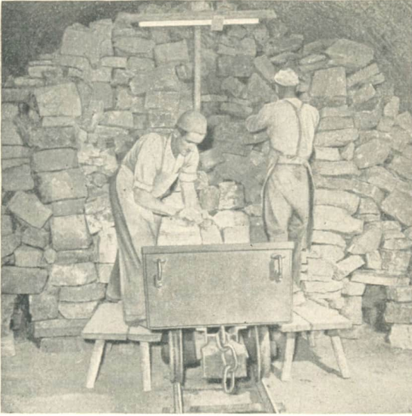
Abb. 59 Eine Kammer im Ringofen des VEB Kalk-, Zement- und Betonwerke Rüdersdorf wird eingekarrt.
