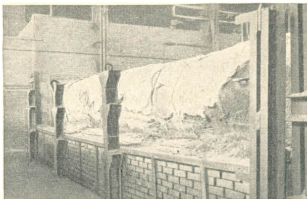
Abb. 69 Siliciumcarbid-Ofen in einem chemischen Großbetrieb der Deutschen Demokratischen Republik
