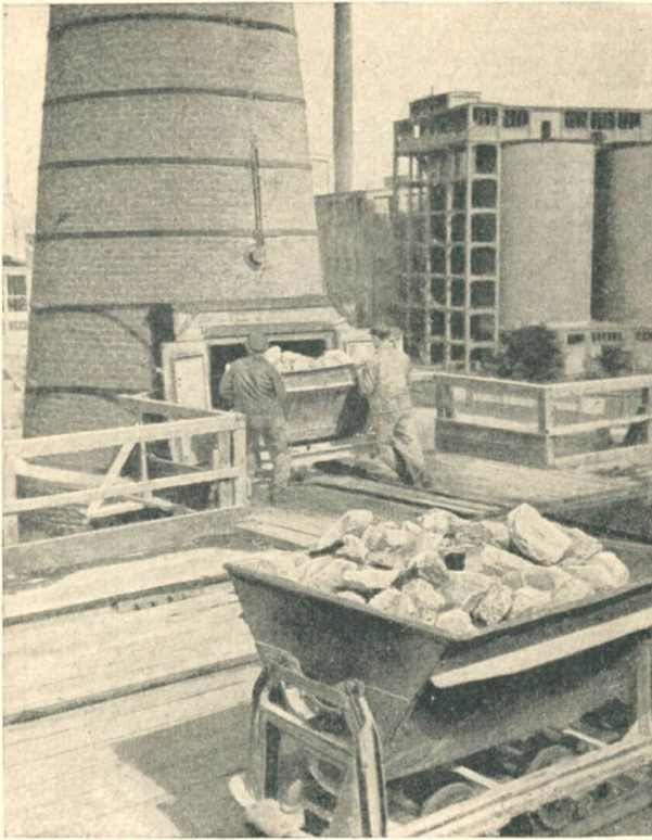
Abb. 63 Füllen eines Schachtofens für Branntkalk
