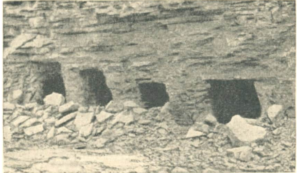
Abb. 57 Eine Kalkwand im Kalksteinbruch Rüdersdorf wird zur Sprengung vorbereitet
