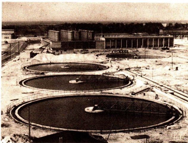
Abb. 187/1 Aufbereitung von Grubenabwässern im Kombinat „Schwarze Pumpe“ (vorn: 3 Absatzbecken, hinten: Filteranlage)
