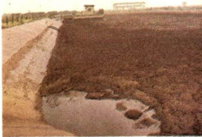
Gülleaufbereitung durch Bakterien
