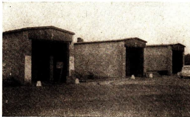
Abb. 18 Kartoffellagerhäuser bei Berlin. Jede Lagerhalle faßt 1000 t Kartoffeln. Sie werden mit Ventilatoren belüftet, die Kartoffeln können deshalb bis zu 3 m hoch aufgeschüttet werden.
