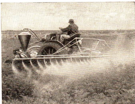
Abb. 231 Mit dem Stäubegerät am Geräteträger werden die Felder gegen Schädlinge bestäubt
