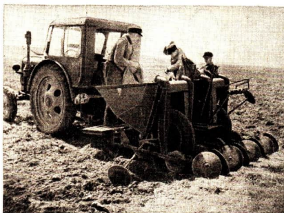
Abb. 19 Kartoffellegemaschine bei der Arbeit.
